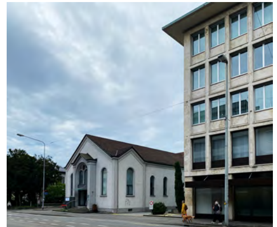
Abb. 5: Foto von Nord-Osten (Bahnhofstrasse) mit Bürogebäude im Westen
